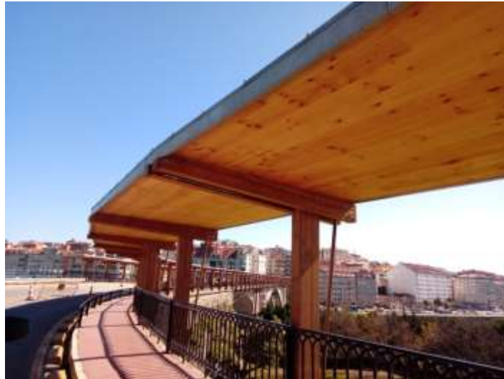
Figura 1: Vista general de la marquesina
