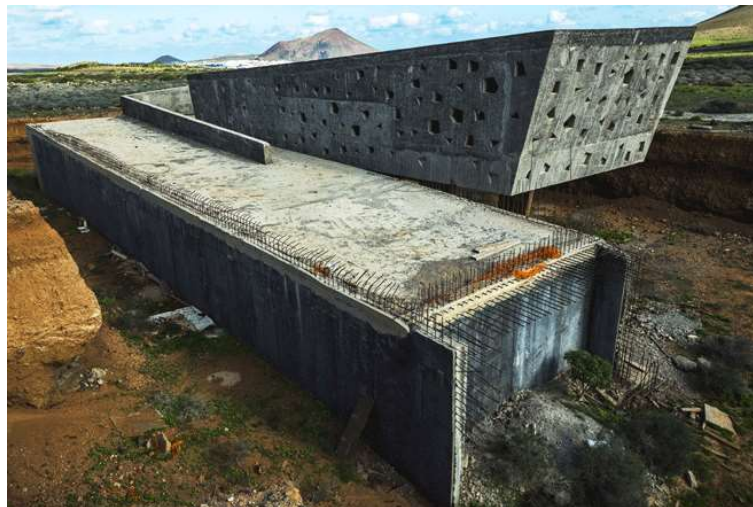
Figura 1: Foto estructura de hormigón preexistente, sector Aula didáctica
