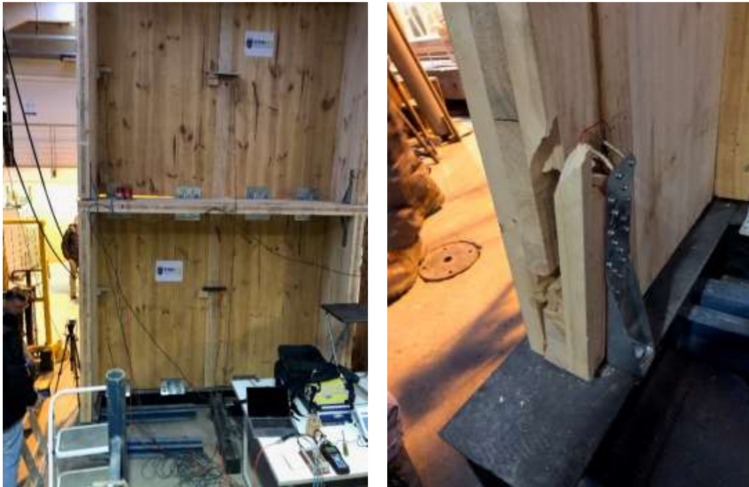
Figura 4: Modos de falla del muro 1 previo al colapso
