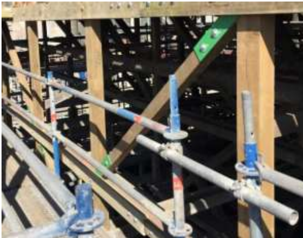
Fig. 17 - Restitución columnas perimetrales
