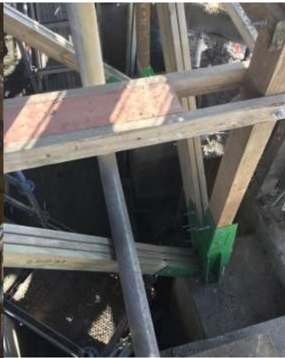
Fig. 20 - Reparación de placas base
