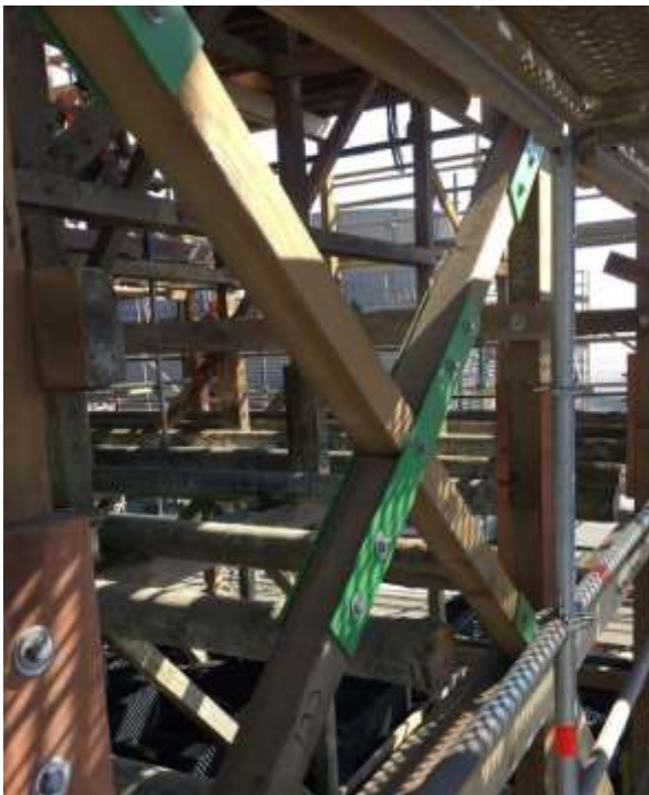
Fig. 19 - Reparación de uniones en arriostramientos
